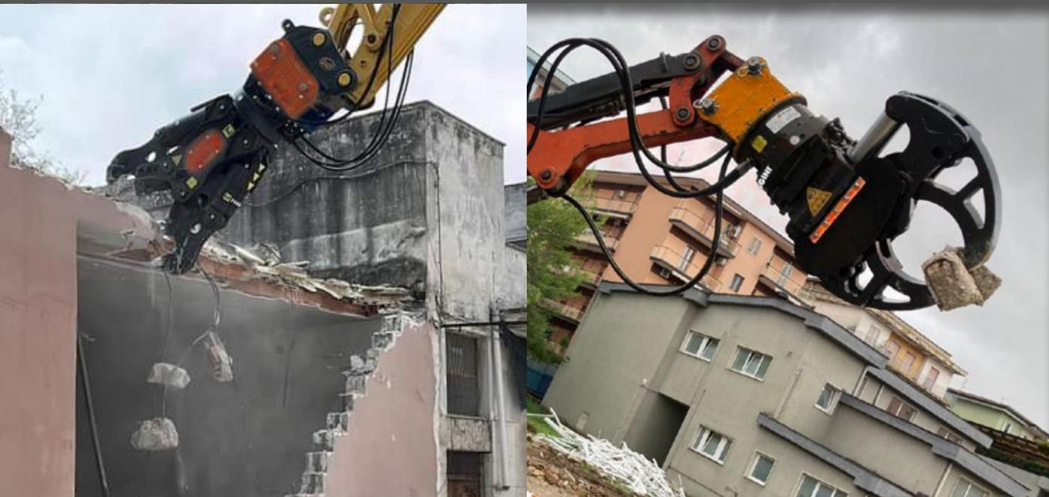
LA SERIE DG ESTÁ DISEÑADA PARA LA DEMOLICIÓN PRIMARIA Y SECUNDARIA, INCLUIDA LA TRITURACIÓN DE MATERIAL PREVIAMENTE DEMOLIDO PARA SU ELIMINACIÓN Y POSTERIOR RECICLAJE. ADECUADA PARA CORTAR Y TRITURAR MATERIALES PESADOS COMO HORMIGÓN CON ARMADURA METÁLICA Y ESTRUCTURAS DE ACERO. ES MUY RESISTENTE GRACIAS A SU ESTRUCTURA DISEÑADA PARA AUMENTAR SU FUERZA DE TRITURACIÓN. SU FÁCIL MANTENIMIENTO ES POSIBLE GRACIAS A SUS MANDIBULAS Y CUCHILLAS FÁCILMENTE REEMPLAZABLES.
